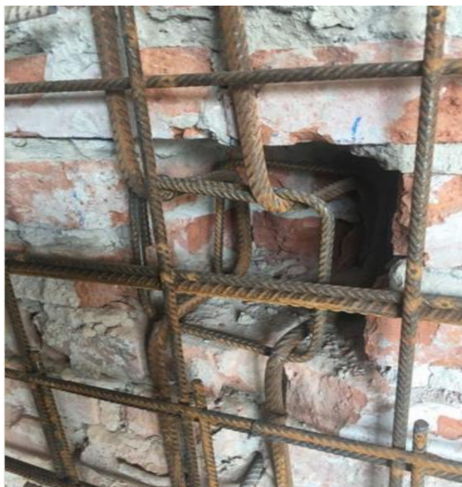
Slika 79: Način postavljanja posmičnih trnova - primjer s gradilišta
