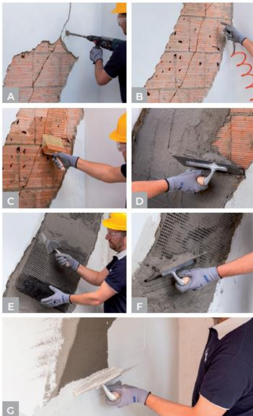
Slika 72 Postupak izvedbe ojačanja FRCM sustavom - praktični dio
