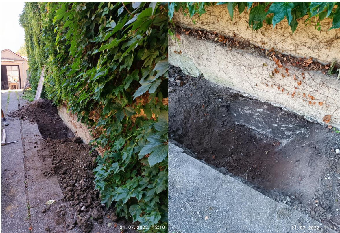
Slika 53: Prikaz provedenih istražnih radova temelja zgrade 2
