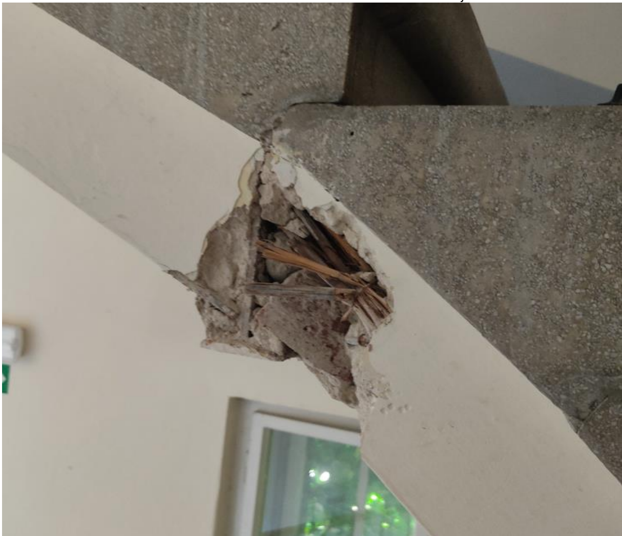
Slika 52 Čelična travezna u konstrukciji stubišta – Pozicija 37
