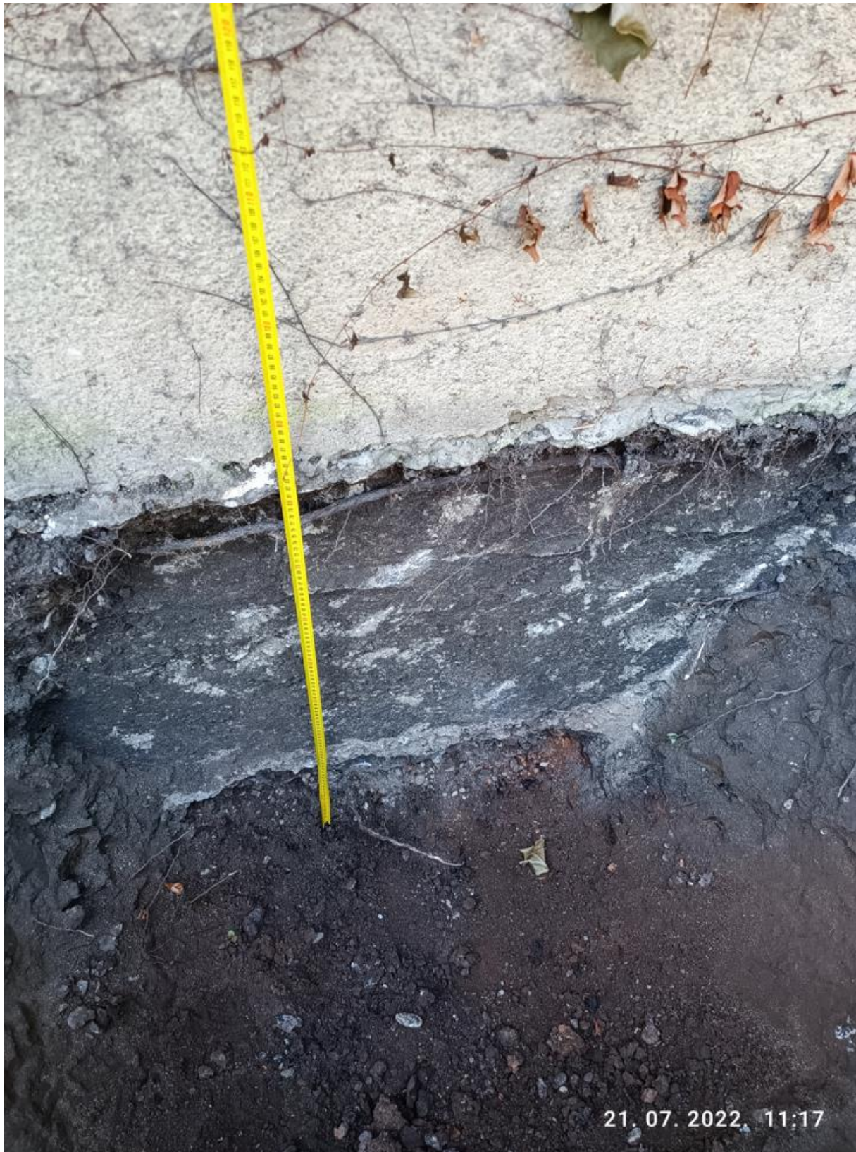
Slika 54:Prikaz provedenih istražnih radova temelja zgrade 2 - Izmjera visine temelja
