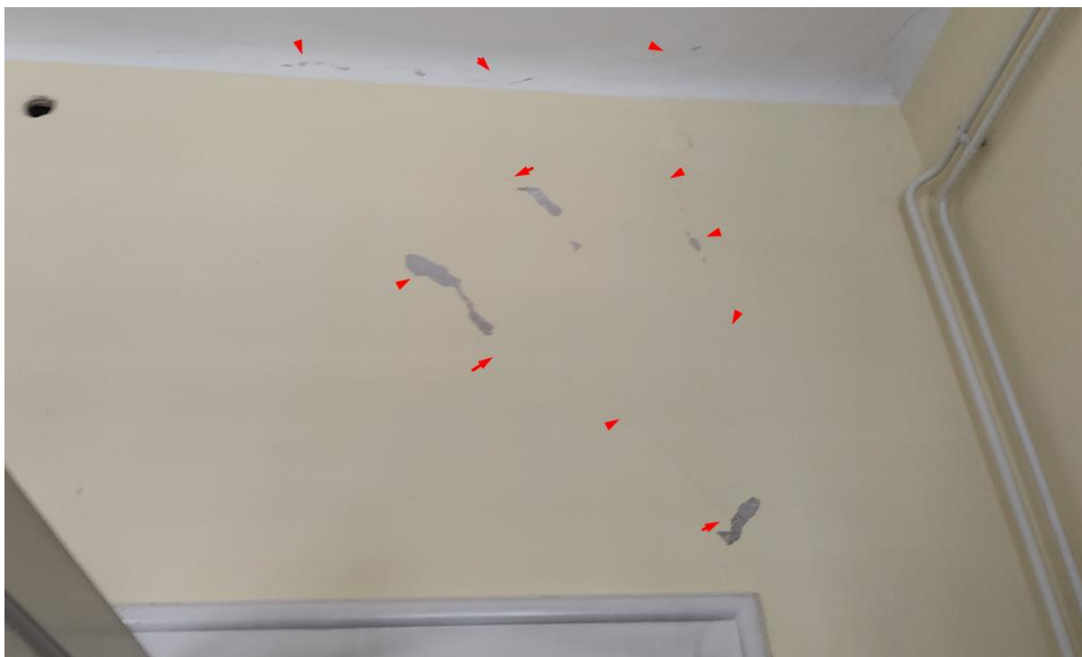
Slika 30 Pukotine na nadvoju iznad otvora na 1. katu – Pozicija 18
