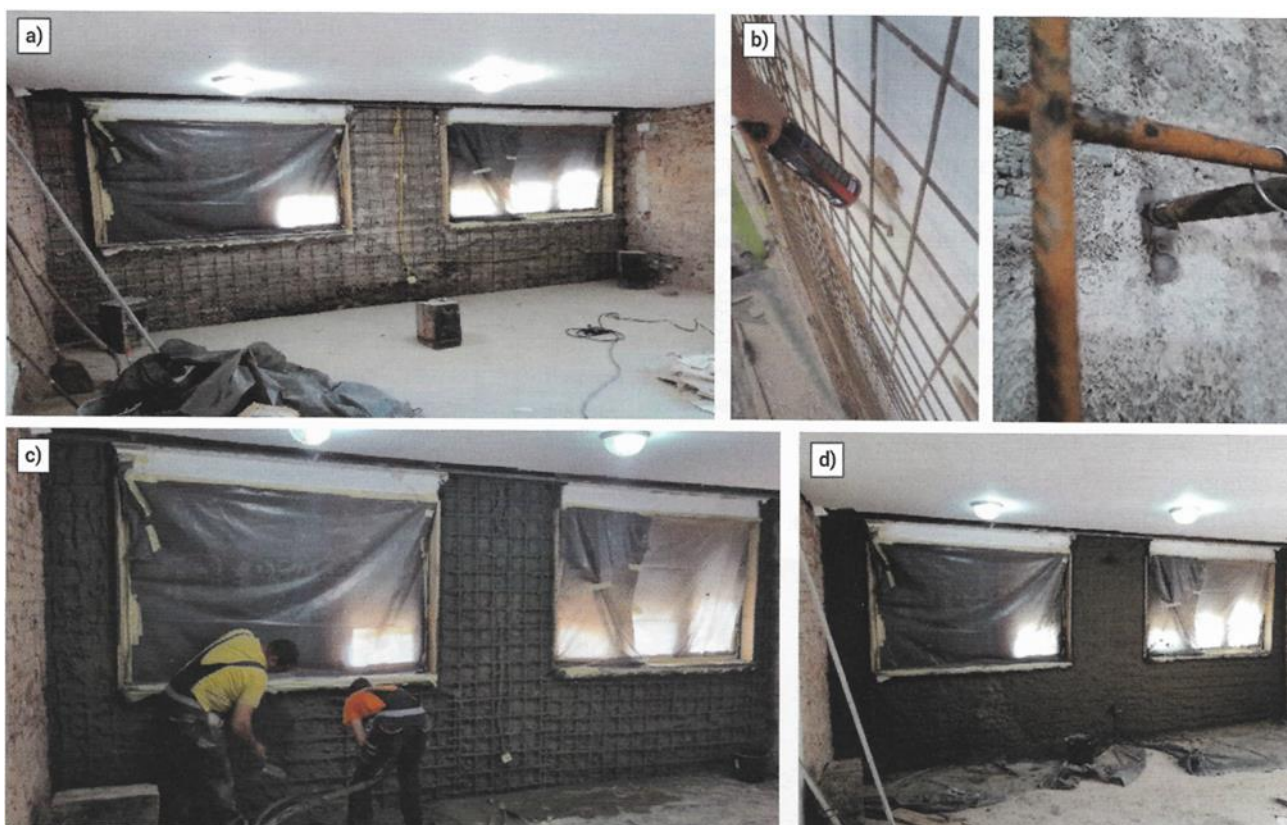
Slika 80: Praktični dio izvođenja radova torkretiranja u etapama: a) postavljanja armatura; b) sidrenje i povezivanje Q mrežom; c) prvi sloj torkreta; d) drugi sloj torkreta.
