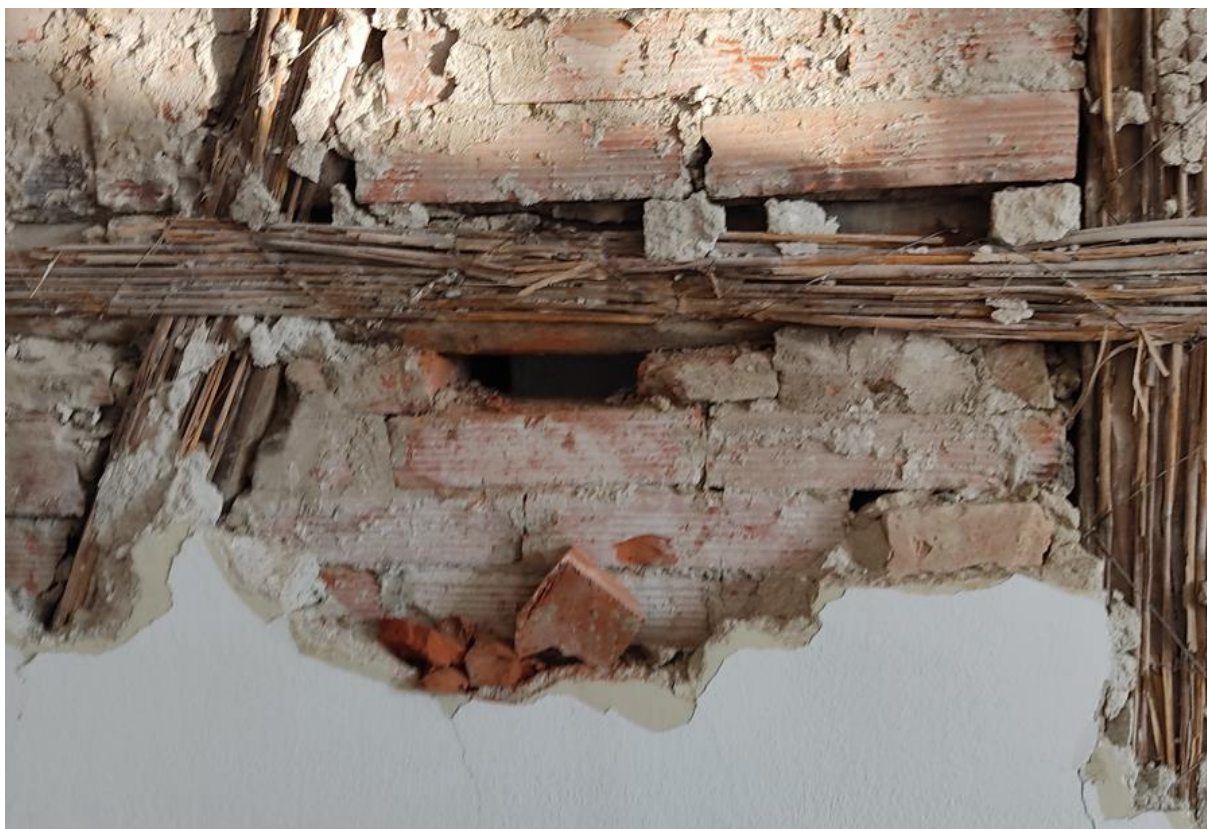
Slika 34 Istražni radovi uklanjanja opeke iz zida – Pozicija 21
