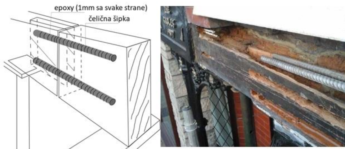
Slika 88: Sanacija drvenih greda čeličnim šipkama i epoksidnim mortom
