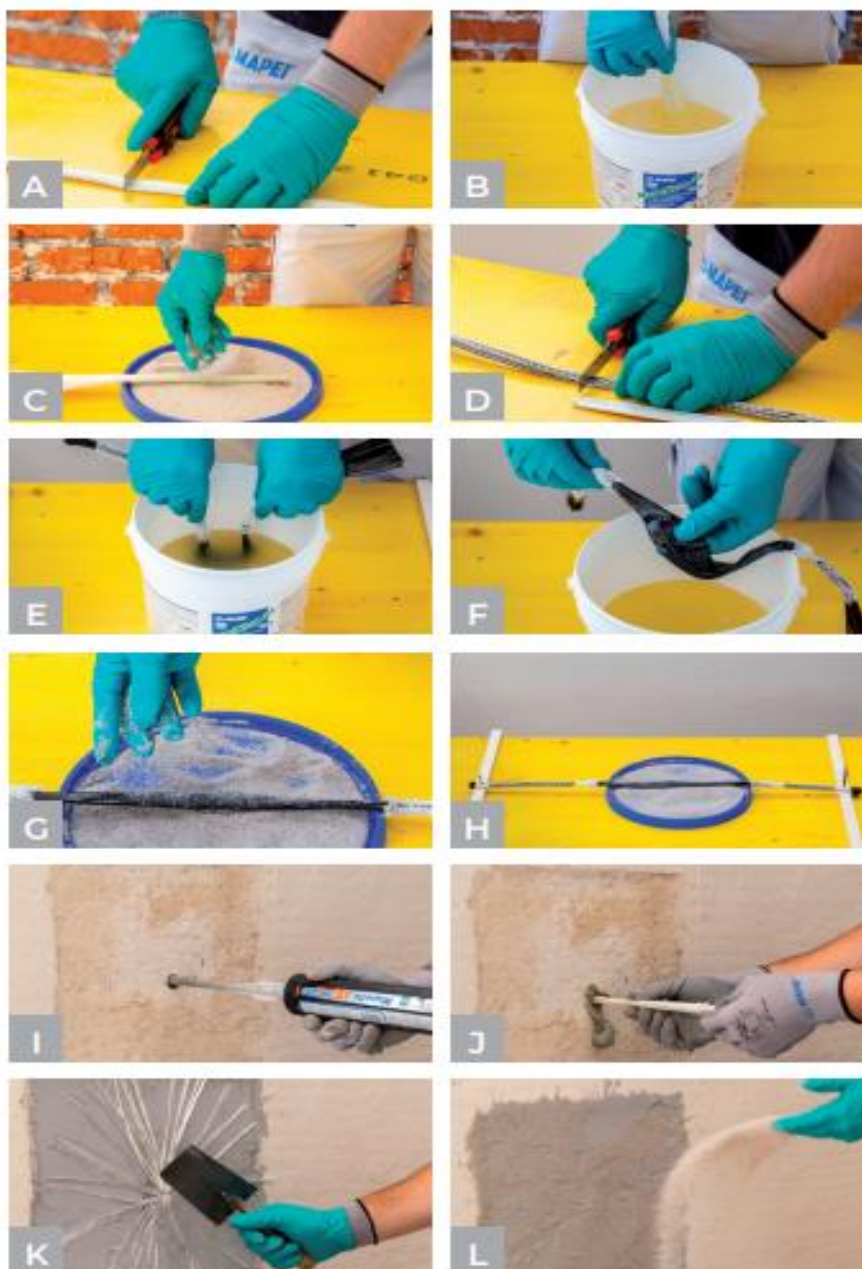
Slika 75 Detalji izvedbe ojačanja sidrima kod jednostranog ojačanja
